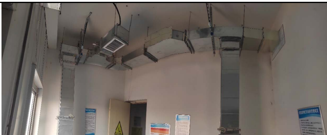
危废暂存间废气排气筒
