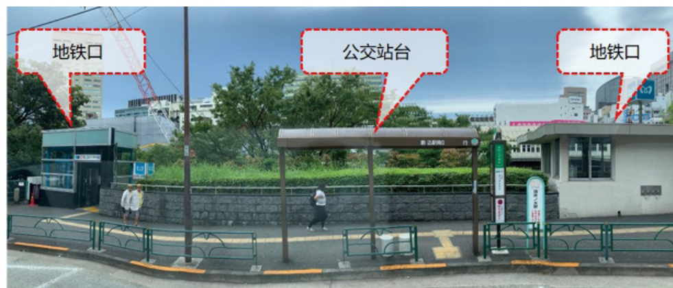
■ 文京区驹入站南公交站台位于两个地铁口中间
